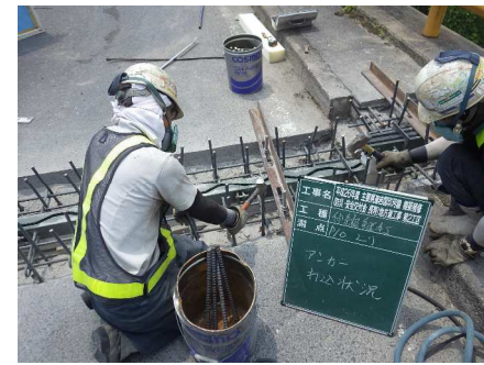
アンカー筋打込
