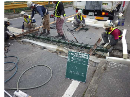
ジョイント据付
