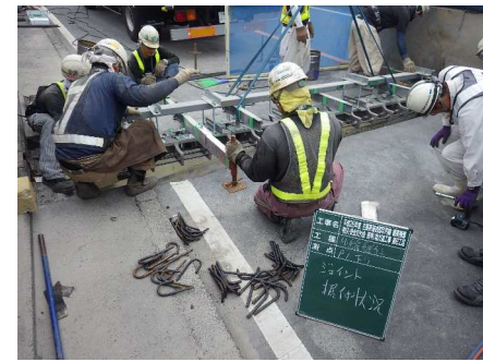
ジョイント据付
