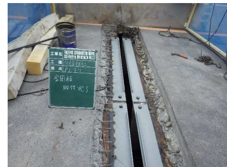
鋼板取付完了
