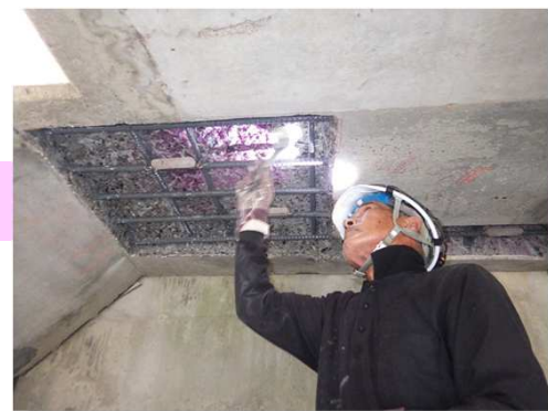
プライマー塗布
