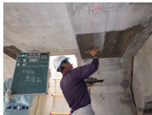
断面修復材充填
