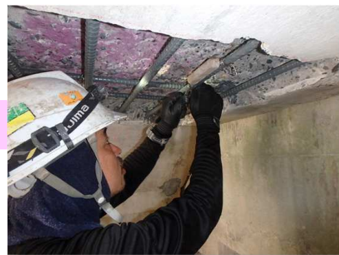
犠牲陽極材設置
