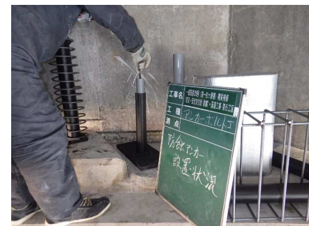
全ネジボルト取付
