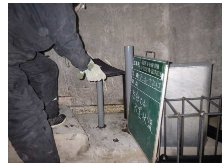
RDパッキン取付
