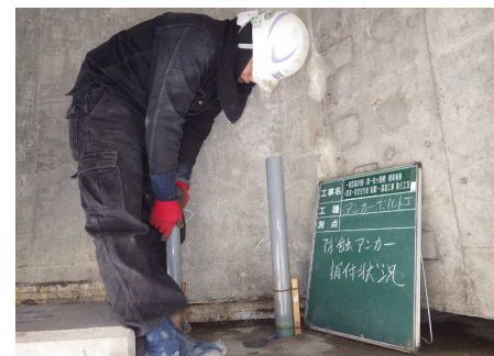
アンカーバー据付
