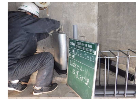
アンカーキャップ取付
