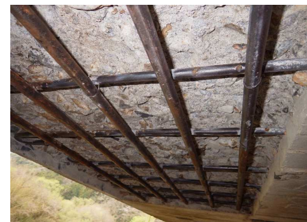
鉄筋ケレン完了
