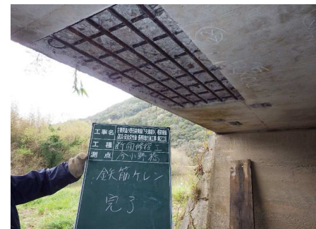
鉄筋ケレン完了
