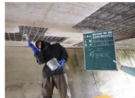
プライマー塗布
