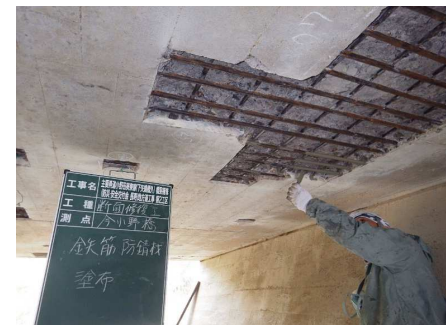
防錆処理材塗布
