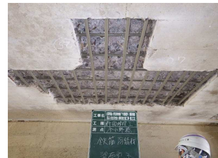
防錆処理完了
