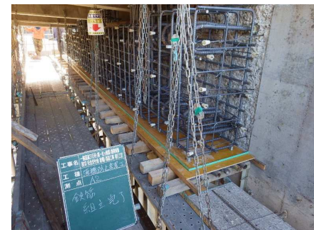
鉄筋組立完了
