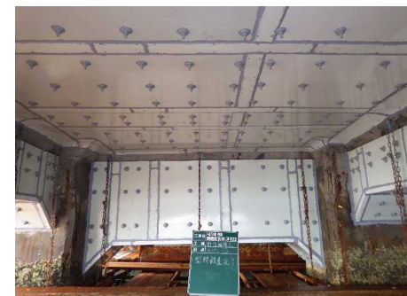
永久型枠組立 ↓
