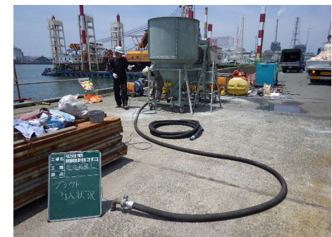
グラウト注入 ↓
