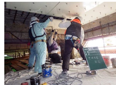
永久型枠組立 ↓
