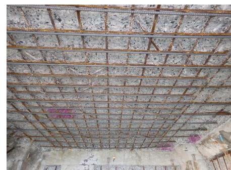
鉄筋補強完了 →
