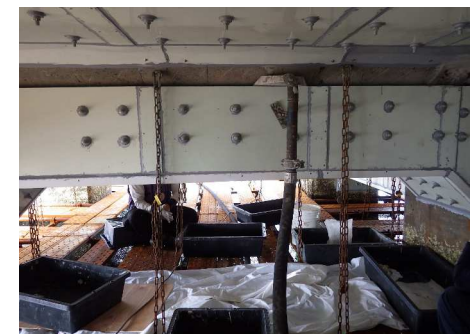
グラウト注入 ↓
