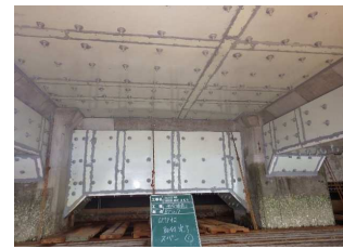
GMP板取付完了
