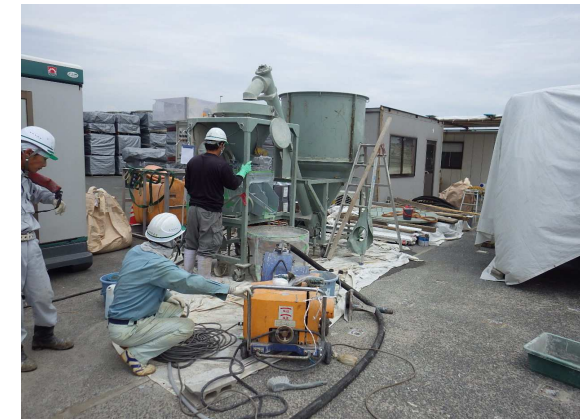
グラウト注入
