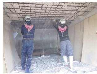
損傷部撤去状況
