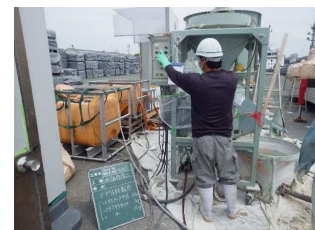
グラウト注入
