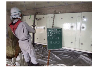
グラウト注入
