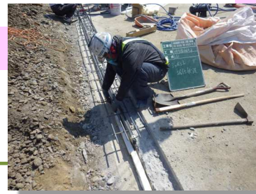
ジョイント据付
