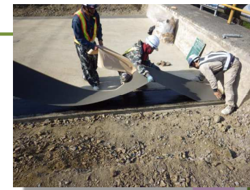
伸縮シート設置
