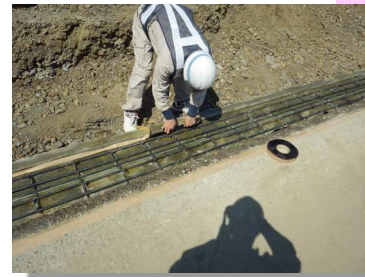
瀝青テープ貼付
