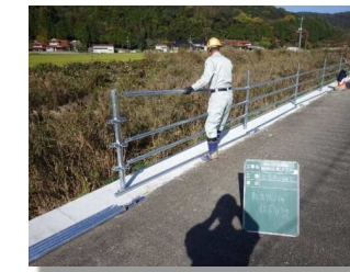
ビームパイプ取付
